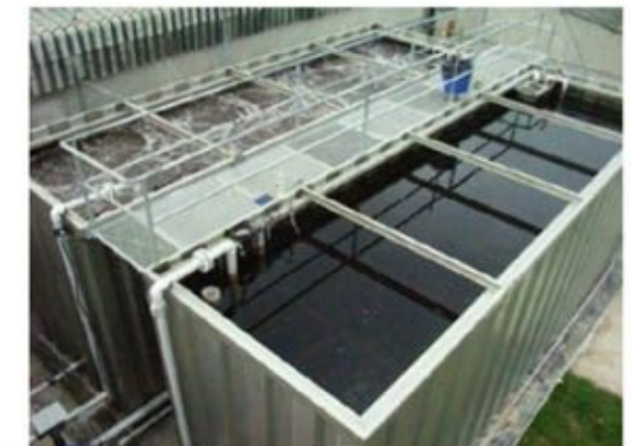
Bacs d'homogénéisation monobloc en béton
